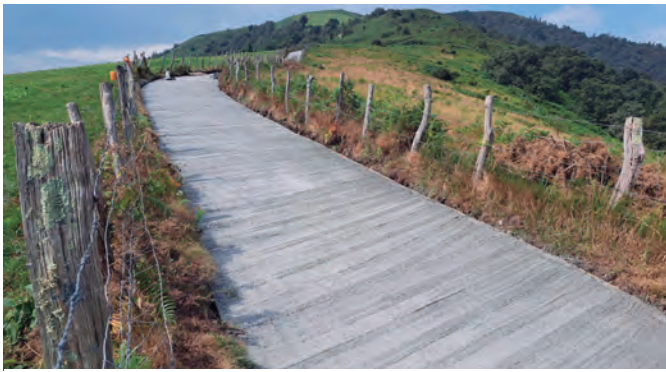
Unanu eta Plantabakar artean 565 metrotan hormigoia eman dute. UTZITAKOA
