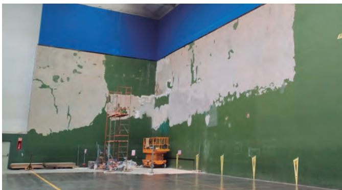
Dagoeneko hasi dituzte pintaketa eta moldaketa lanak. UTZITAKOIA
