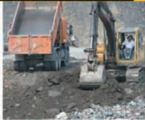
Usainaren arazoari aurre egiteko, zikinak lauzpabost hilabetez mintz iragazgaitz batekin estaliko dituzte eta noizbehinka lur arruntarekin.
