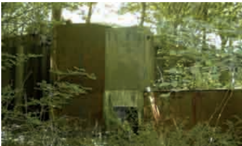
Gaur egungo depuradora.
