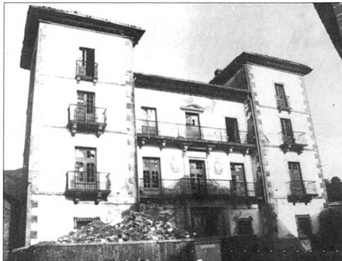
Erratzuko aduana zaharrean zenbait moldaketa egiten ari dira
