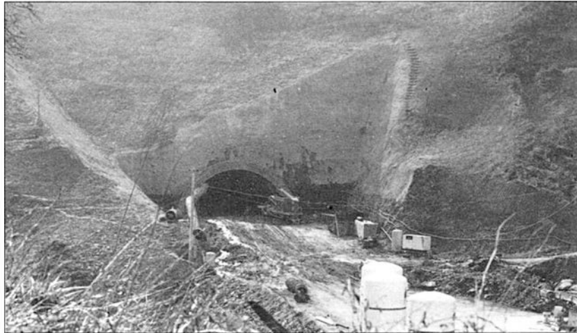
Tunelean 25 metro inguru zulatu dute dagoeneko.
