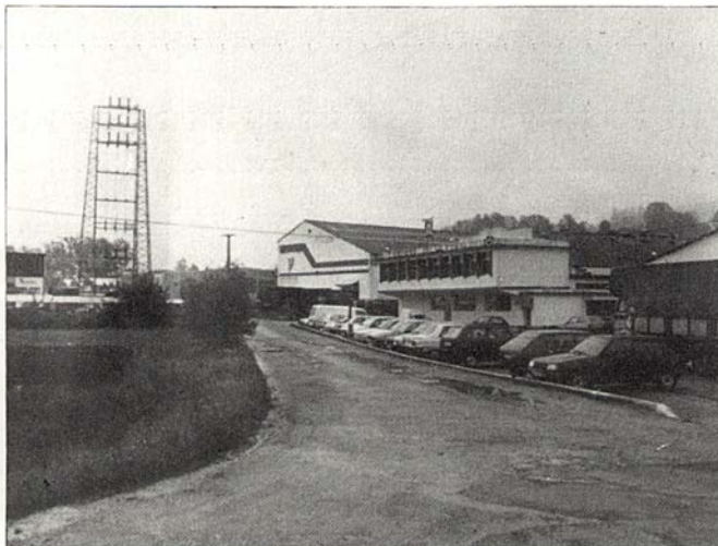
Gas-naturalak Berako industrialdea hornituko du laister
