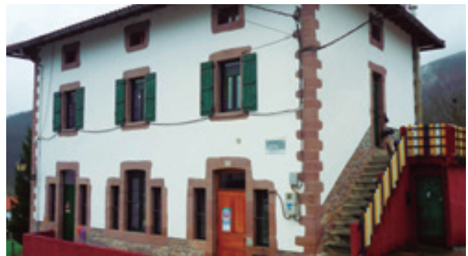
Hiru solairuak lotzeko eskailerak eta igogailua paratuko dute. ARTXIBOTIK
